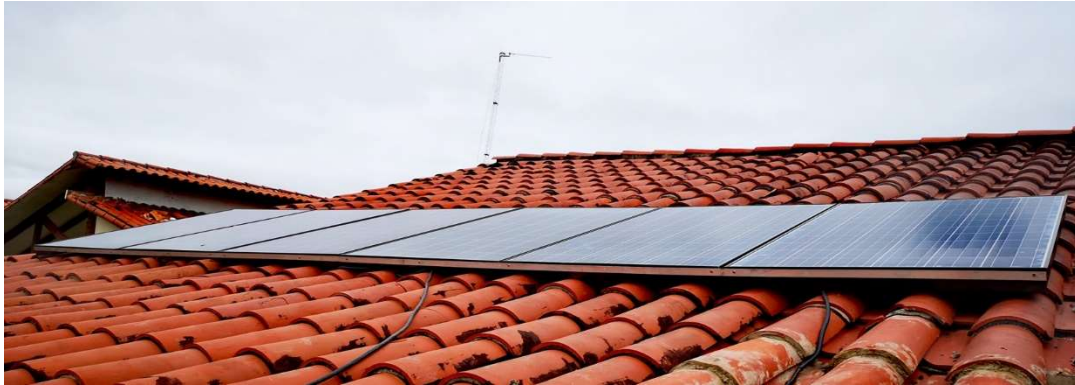
Sistema aislado hibrido de 6 kW. San Javier "Aguas Tibias"
