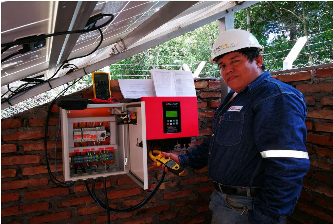
Sistema de bombeo solar de 2 kW. FPS "San Ramón"
