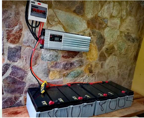
Sistema aislado hibrido de 5 kW. Porongo "La Orilla"
