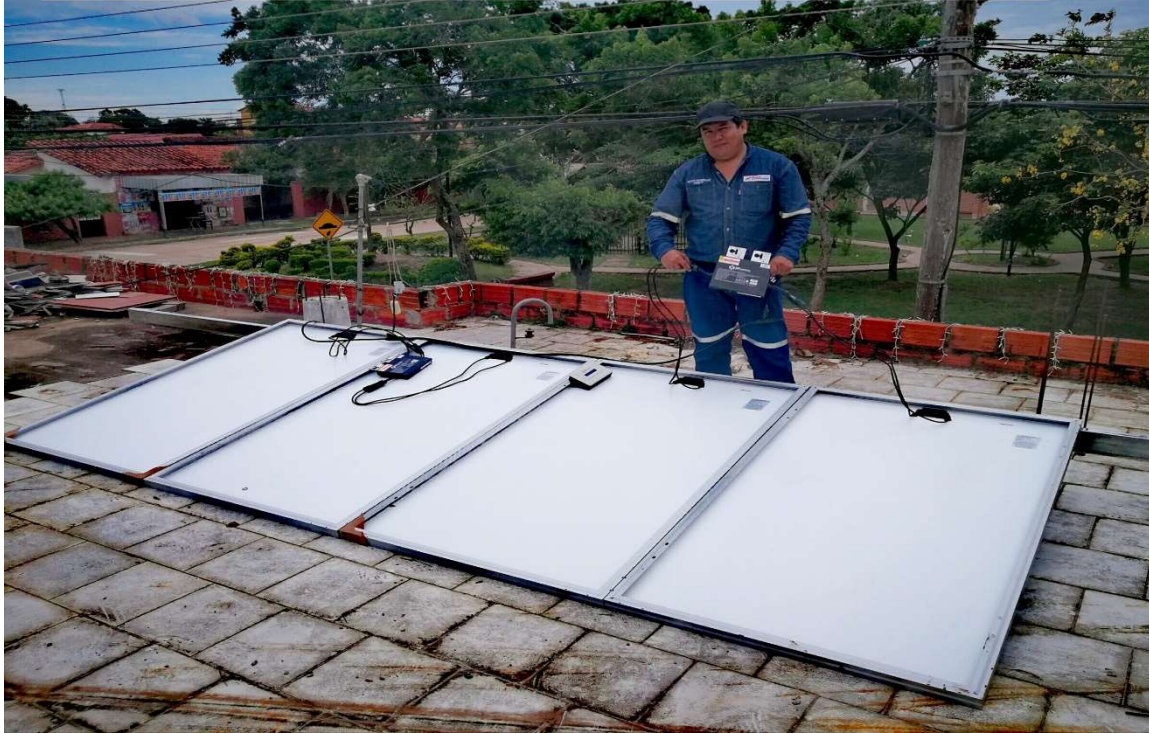
Sistema de bombeo solar de 2 kW. FPS "San Ramón"
